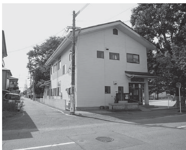
図-2 公園内の集会所施設の例（泉ヶ丘校区公民館）
