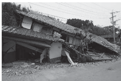
写真－1 母屋の被害（西原村大切畑）
