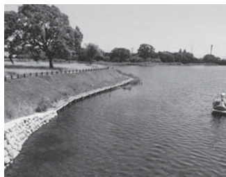
写真-4 多自然工法を取り入れた護岸
