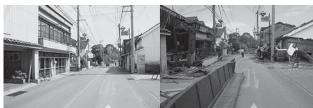
写真－２ 県道の地震前後の比較（益城町資料より）
