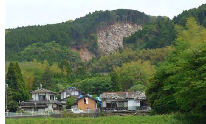
西原村人工植林部 土砂崩れ（平成28年5月5日撮影）
