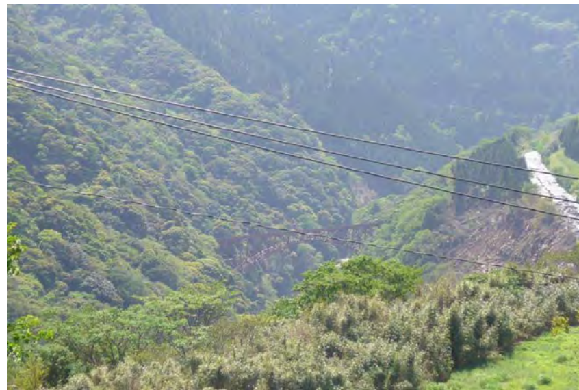
南阿蘇鉄道第一白川橋梁（平成28年5月5日撮影）
